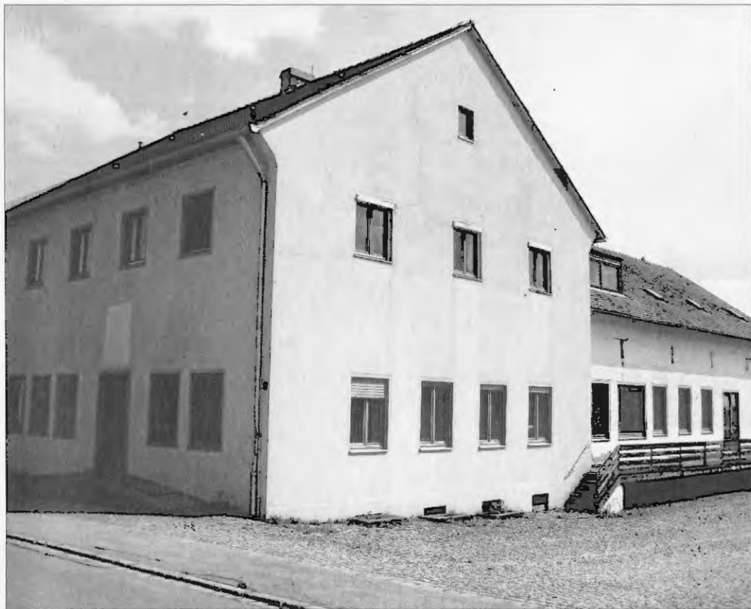
Das alte Rathaus soll im kommenden Jahr abgerissen werden.
