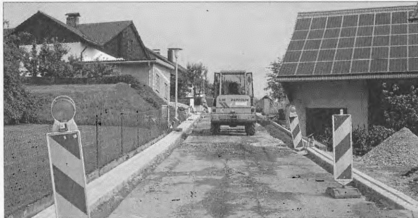
Die Sanierungsarbeiten am Dachsenbachweg laufen bereits.
